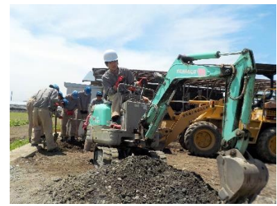
環境工学コース 建設機械実習（バックホー）
