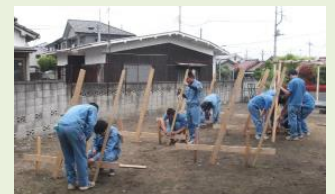
選択実習(3年) 丁張り設置
