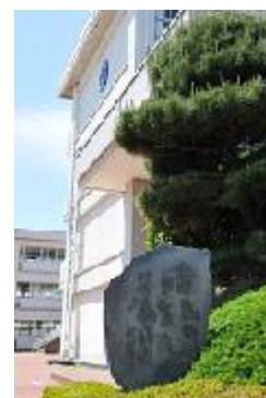
管理棟(手前)と教室棟(左奥)
