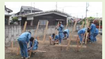
選択実習(3年) 丁張り設置
