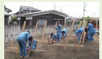
選択実習(3年) 丁張り設置
