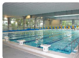
第二体育館(25m室内温水プール)
