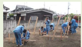
選択実習(3年) 丁張り設置
