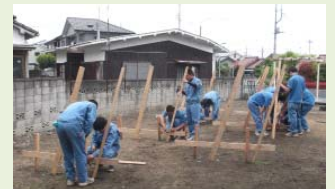
選択実習(3年) 丁張り設置
