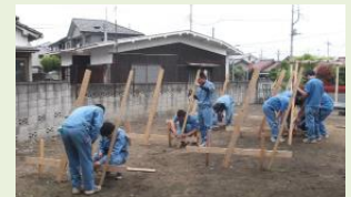
選択実習(3年) 丁張り設置
