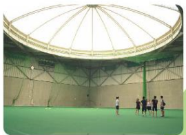
屋内運動場(ドーム)
