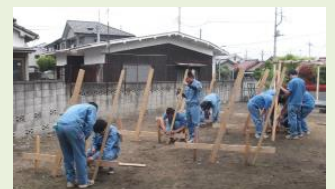
施工実習 (丁張り設置)
