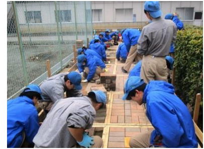
環境工学コース 施工実習（インターロッキング敷設）
